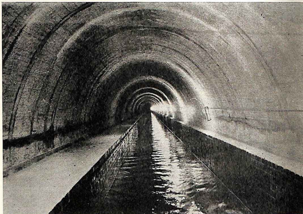
Η σήραγξ τού άγωγού, μήκους τεσσάρων χιλιομέτρων
