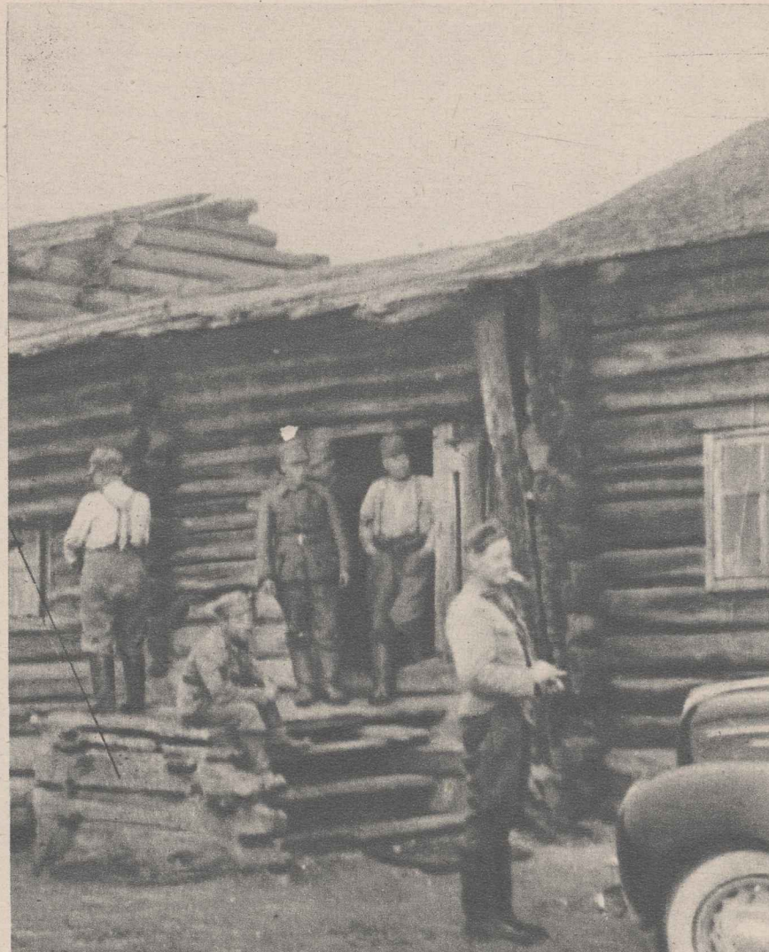
Αἱ ΚΑΤΟΙΚΙΑΙ ἀπὸ κορμούς, κτισθεῖσαι διὰ τοὺς ἐργάτας τοῦ Κολχόζ (ἡ ἐξωτερικὴ ἀποψὶς τῶν εἶναι τελείως σύμφωνος πρὸς τὰς ἐσωτερικὰς συνθήκας), ἐχρησίμευον ὡς κατοικίαι εἰς τοὺς «οὐλαμούς» τῶν σκλάβων τῆς γῆς. Ἐλλείπει ἄλλων καλλιτέρων, οἱ Φινλανδοὶ αὐτοὶ στρατιῶται τὰς ἐχρησιμοποίησαν, μόλις ἔφθασαν εἰς τὸ σημεῖον ἐκεῖνο τῆς Καρέλιας.
