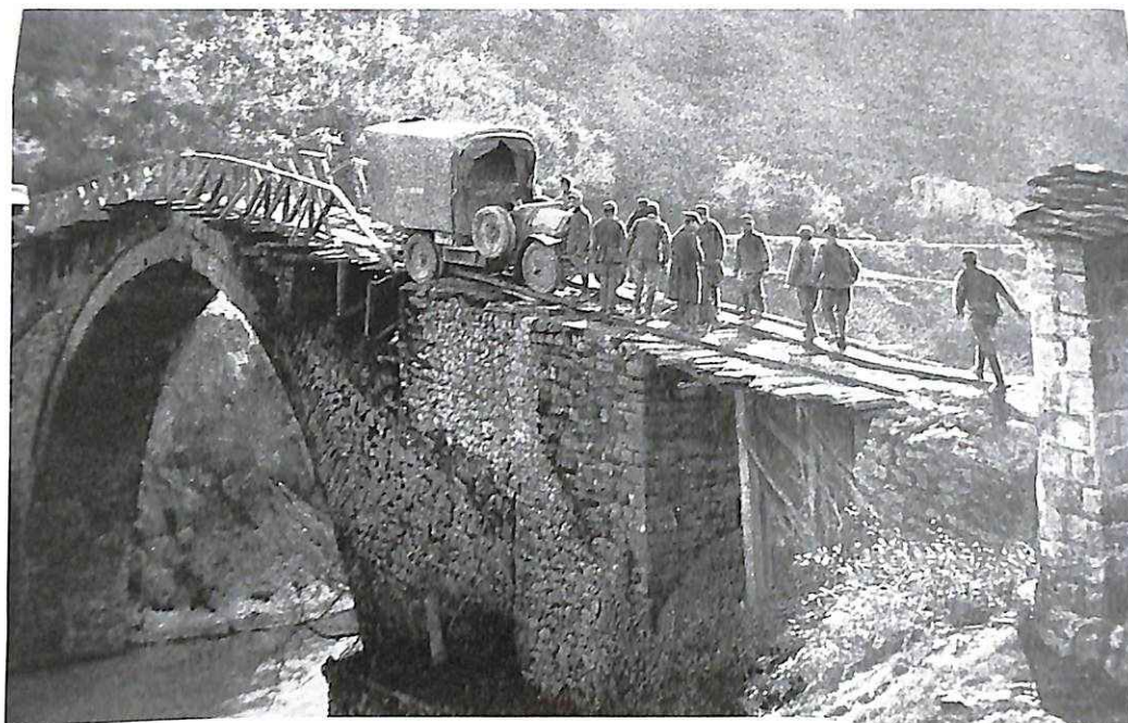
Εφημ. L'Illustration 17-03-1917. Ένα φορτηγό αυτοκίνητο σε επικίνδυνη θέση πάνω στη γέφυρα του Σαραντάπορου [Μέρτζιανης], στα ελληνοαλβανικά σύνορα.
