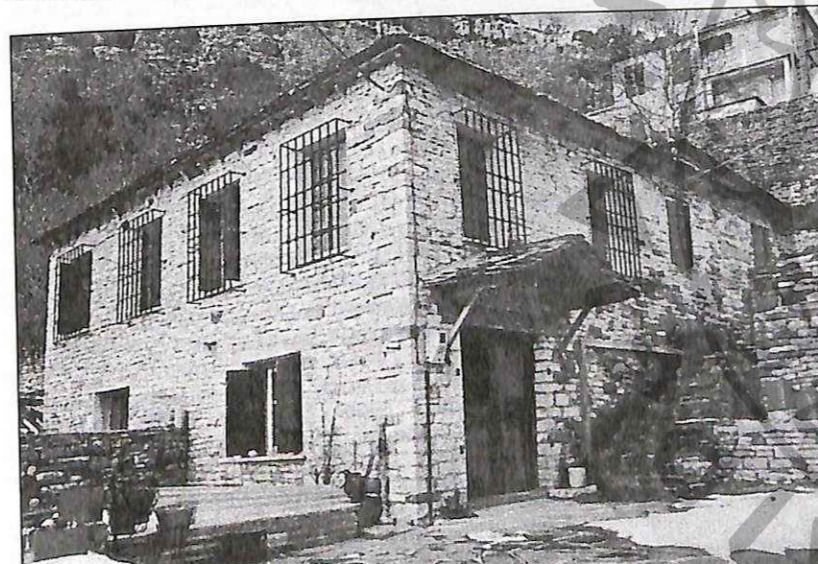
Το Καπέσοβο Παιδοστάσιο Ζαγορίου. Καπέσοβο Ζαγορίου Ιωαννίνων - τηλ. 26530 71724, κιν. 6945 529357
