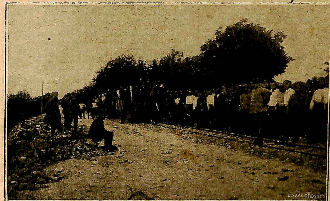
Εἰς τὸ ἔργον: Ἀξιωματικοὶ καὶ στρατιῶται 1 λόχου III Διλοχίας Μηχανικοῦ ἐργαζόμενοι διὰ τὴν κατασκευὴν σιδηροδρομικῆς γραμμῆς decovile τῆς δημοσίας ὁδοῦ Προύσης-Τομπόλ.
