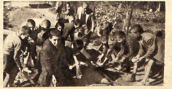
Ε.Σ.Ν. Δημ. Σχολ. Άγ. Γεωργίου Λασιθίου. Κατασκευή δρόμου. Juniors of Elem. School Aghios Georgios Lasithiou. Road construction.
