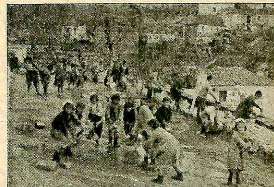
↑ Ε.Σ.Ν. Δημ. Σχολ. Κουκουράβας Λαρίσης επισκευάζουν την αυλήν του σχολείου. Juniors of Elem. School Koucourava repairing their play ground.
