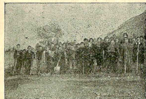
↑ Ε.Ε.Ν. μαθ. Δ. ημ. Σχολ. Ἀργυροχωρίου Φωκίδος διορθώνουν κοινοτικὴν ὁδόν. Juniors of Elem. School Argyrochori repairing a village road.
