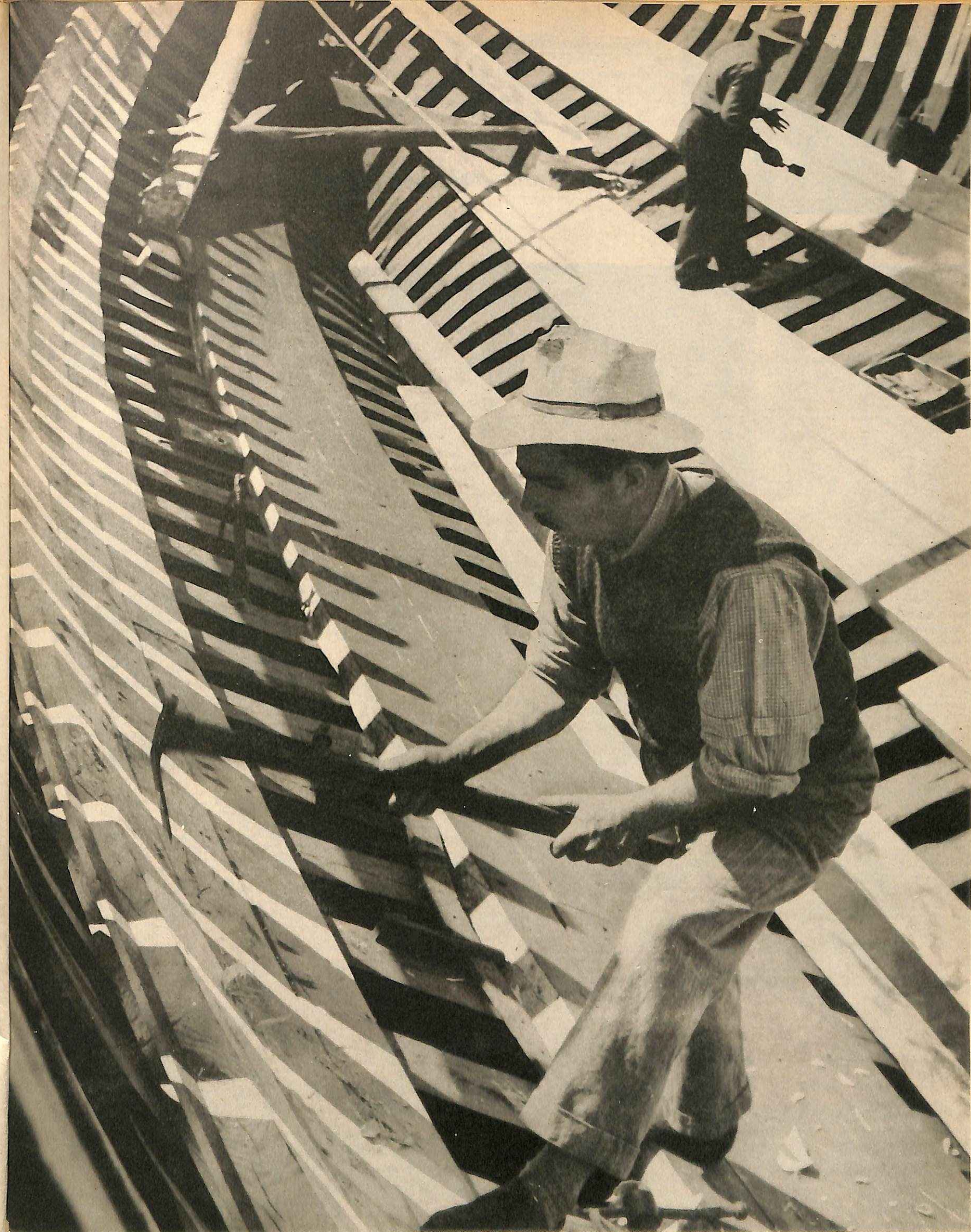
Ο ΣΚΕΛΕΤΟΣ ΤΟΥ ΞΥΛΙΝΟΥ ΣΚΑΡΙΟΥ «ΠΕΤΣΩΝΕΤΑΙ» ΜΕ ΓΕΡΕΣ ΣΑΝΙΔΕΣ. ΣΕ ΛΙΓΕΣ ΜΕΡΕΣ ΘΑ ΚΥΛΗΣΗ ΣΤΗΝ ΑΓΚΑΛΙΑ ΤΗΣ ΘΑΛΑΣΣΑΣ
