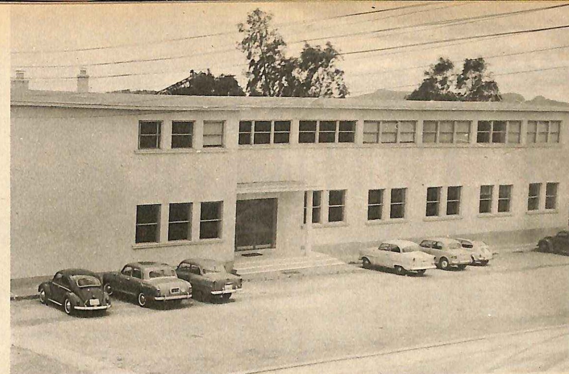
ΤΟ ΚΤΙΡΙΟ ΤΩΝ ΓΡΑΦΕΙΩΝ ΤΩΝ ΝΑΥΠΗΓΕΙΩΝ ΕΧΕΙ ΚΤΙΣΘΗ ΜΕ ΤΙΣ ΤΕΛΕΥΤΑΙΕΣ ΑΝΕΞΕΙΣ
