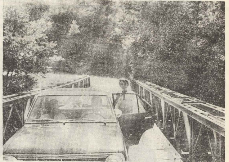
Η αποξυλωθείσα γέφυρα ΜΠΕΛΕΥ στον ποταμό Καλαμά.
