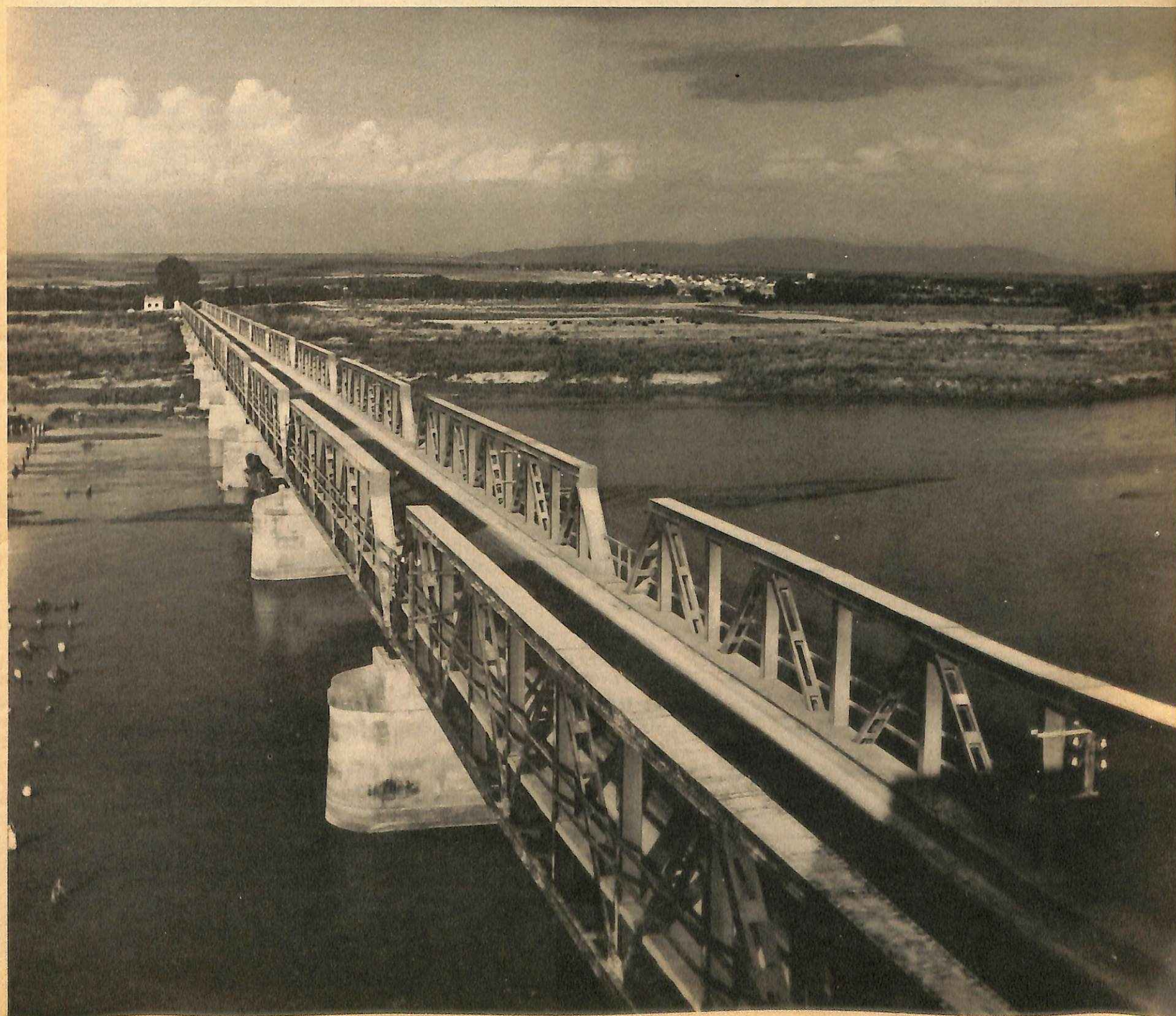
Η ΝΕΑ ΓΕΦΥΡΑ ΤΟΥ ΑΞΙΟΥ (Η ΠΑΛΙΑ ΚΑΤΕΣΤΡΑΦΗ ΣΤΗΝ ΚΑΤΟΧΗ) ΕΧΕΙ ΜΗΚΟΣ 480 ΜΕΤΡΑ ΚΑΙ ΣΤΗΡΙΖΕΤΑΙ ΕΠΑΝΩ ΣΕ ΔΩΔΕΚΑ ΒΑΘΡΑ
