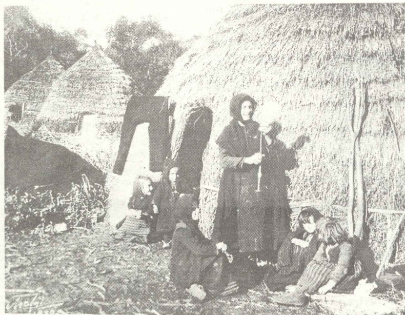
Σαρακατσάνοι στο Ζαγόρι, 1936. Φωτ. Νέλλης, Αρχείο ΡΕΣ.
