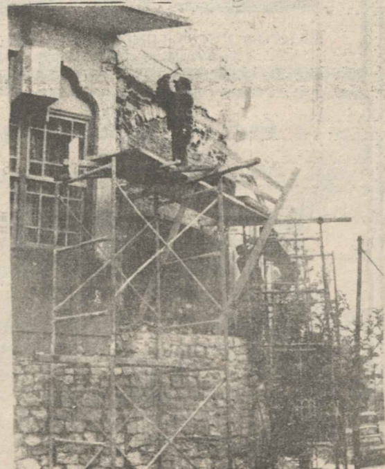
Οικοδομικές εργασίες στο άλσος για τον 2' παιδικό σταθμό
