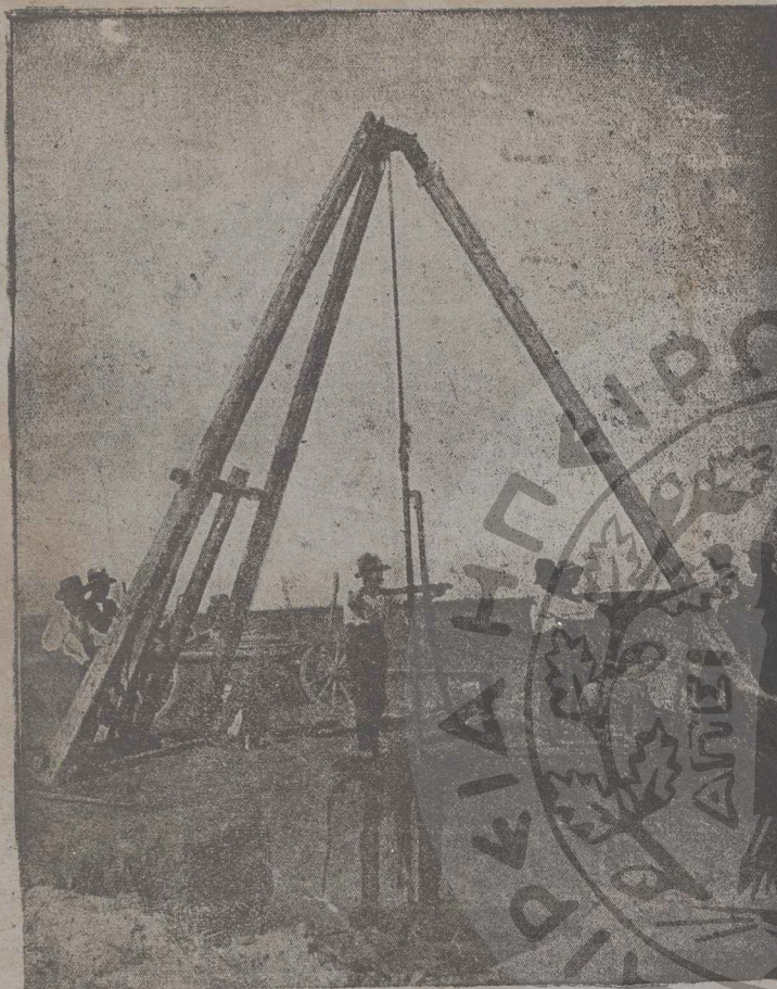
Γεωτρύπανον χειροκίνητον υδραυλικῆς πίεσεως ἐν λειτουργίᾳ εἰς τὴν ὕπαιθρον ἐν Μακεδονίᾳ.
