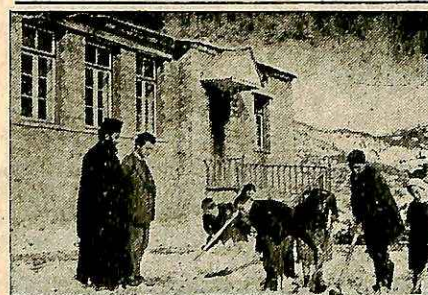
Ε.Σ.Ν. μαθ. δημ. σχολ. Μακρινου—Ζαγορίου ἀνοίγουν δρόμον διὰ τὴν ἐκκλησίαν. Juniors of Elem. School Makrinon Epirus constructing the road to the village church.
