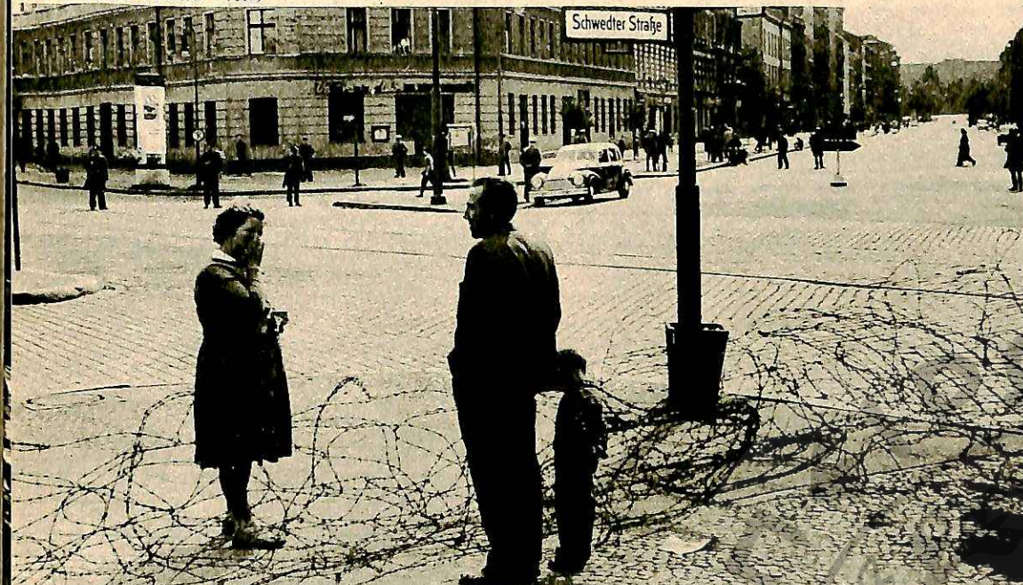
...ΠΑΤΕΡΑ, ΠΟΥ ΒΡΙΣΚΕΤΑΙ ΑΣΦΑΛΗΣ ΣΤΟ ΔΥ ΤΙΚΟ ΤΟΜΕΑ, ΚΑΙ ΑΝΑΛΥΕΤΑΙ ΣΕ ΔΑΚΡΥΑ.
