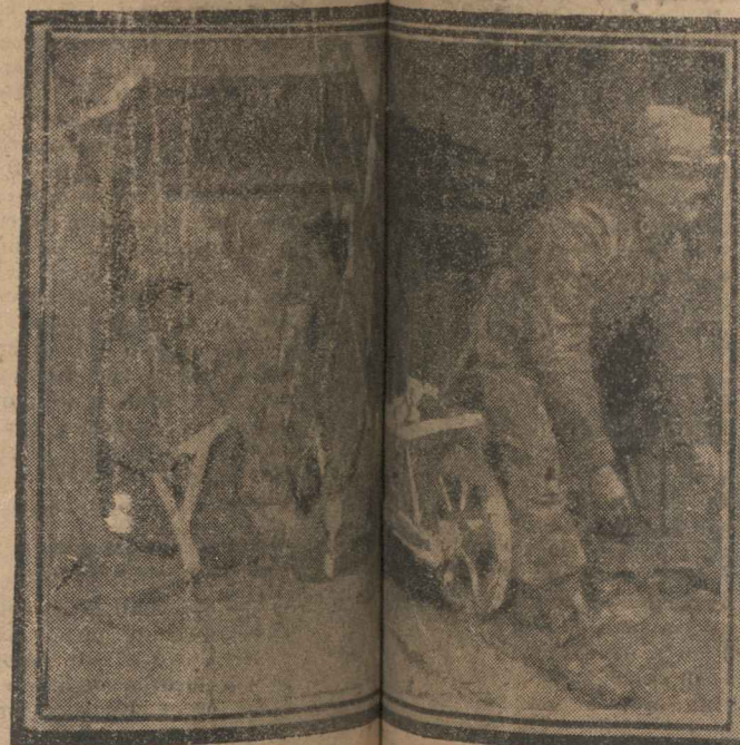
Φωτογραφία ληφθεῖσα ἐντὸς τῶν προχωμάτων καὶ παριστάτω στρατιώτην μεταφέροντα ἀπὸ ὑπόγειον ἐργασίαν.
