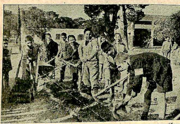
Ε.Ε.Ν. 1ου Δημ. Σχολ. Μαγχουφάνας κατασκευάζουν προστατευτικὸν πεζοδρόμιον εἰς τὴν αὐλὴν τοῦ σχολείου των Juniors of 1st Elementary School Mangouphana helping in the reconstruction of their school
