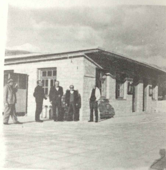
1974: Αποπεράτωση του Α' ορόφου και πλακόστρωση πλατείας (Μεσοχώρι). (Ένα από τα κυριότερα έργα του Συλλόγου).
