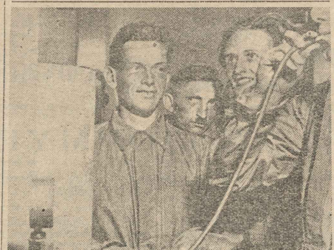
Οι μαθηταί πριν άρχίσουν έξάσκησιν με τας αντιασφυξιόγουνους προσωπίδας, δοκιμάζουν εις μίαν συσκευήν την πίεσιν της ανασπνοής των και την ποσότητα του αέρος που εύρίσκεται έντός των πνευμόνων.
