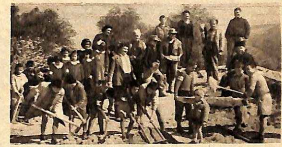
Ε.Ε.Σ.Ν. Δημ. Σχολ. Κισάμου Χανίων βοηθοῦν εἰς τὴν ἀποπεράτωσιν τοῦ Σχολείου των. Juniors of Elem. School Kissamos Chania helping for the completion of their school.
