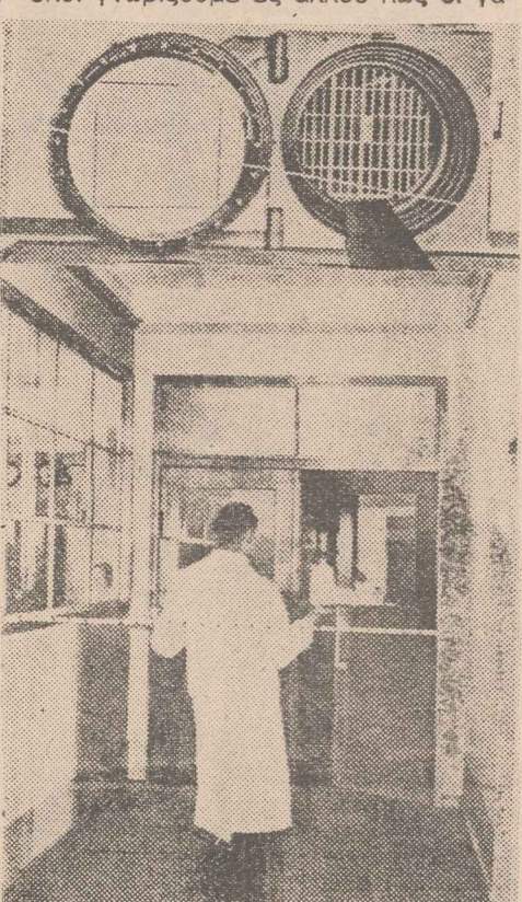
Άνω: Άόρατοι ακτίνες φρουρούν πρσ αυτής της εισόδου. Κάτω: Όταν ό φύλαξ πέρσση από τις άόρατες ακτίνες, ή πόρτα άνοίγει αυτομάτως.
