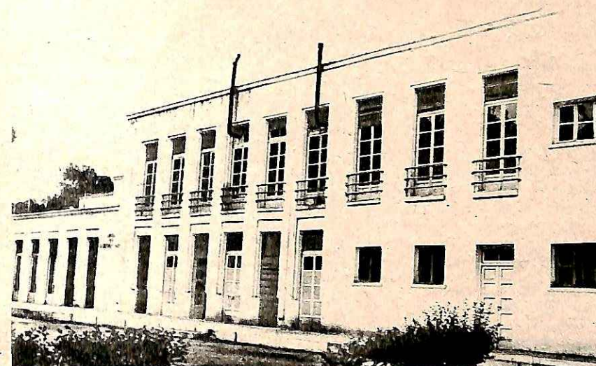
Τὸ ἴδιο τμήμα μετὰ τὴν ἐπισκευή του, με δωρεά τοῦ Ἑλβετικοῦ Ε. Σ.
