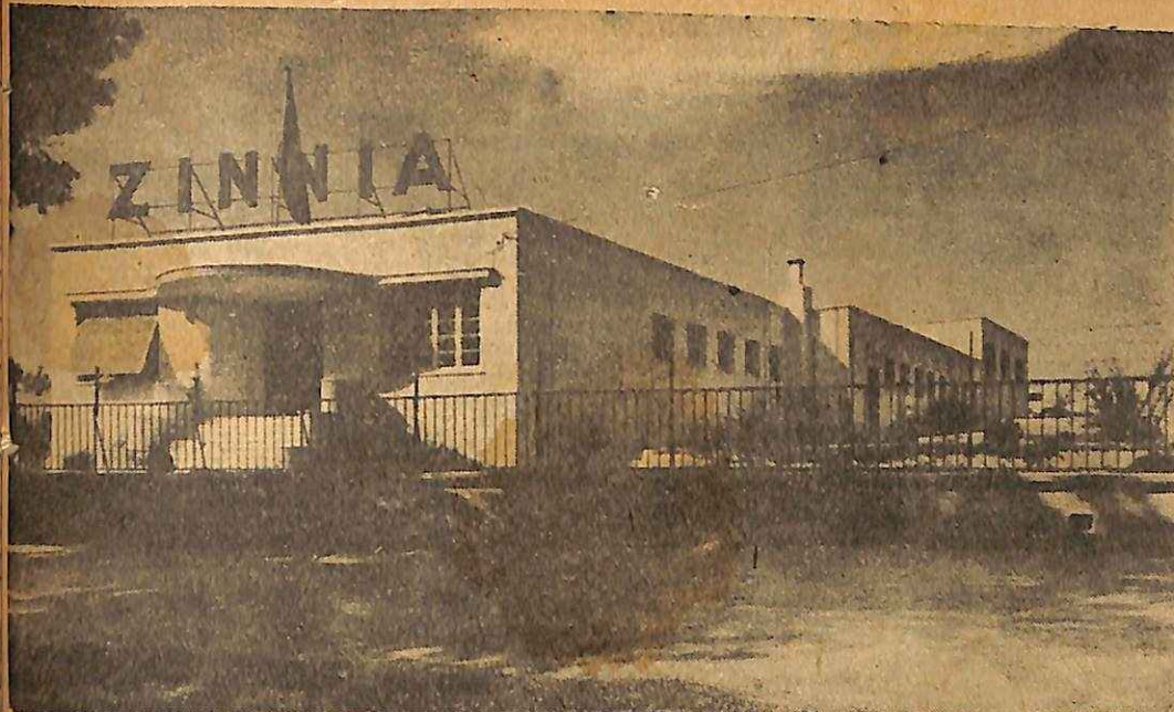
Οι κτιριακές εγκαταστάσεις του εργοστασίου καλλυντικών ZINNIA.
