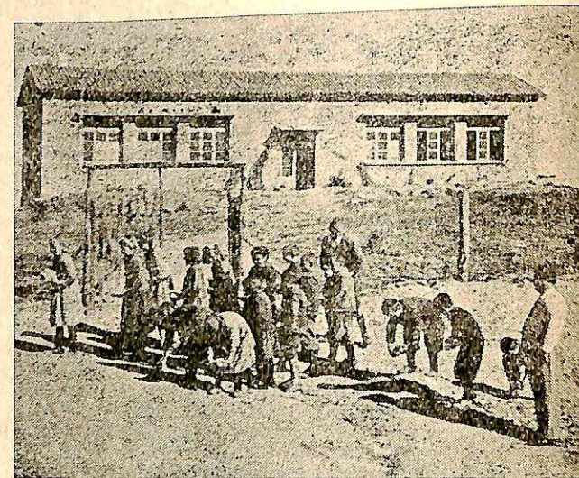
ΕΕΣΝ μαθηταὶ τοῦ Δημ. Σχολ. Κυδωνίων Γρεβενῶν μεταφέροντες ὕλικά διὰ τὴν ἀνέγερσιν τῆς ἐκκλησίας. Juniors of Elem School Kydonion, Macedonia working for the reconstruction.
