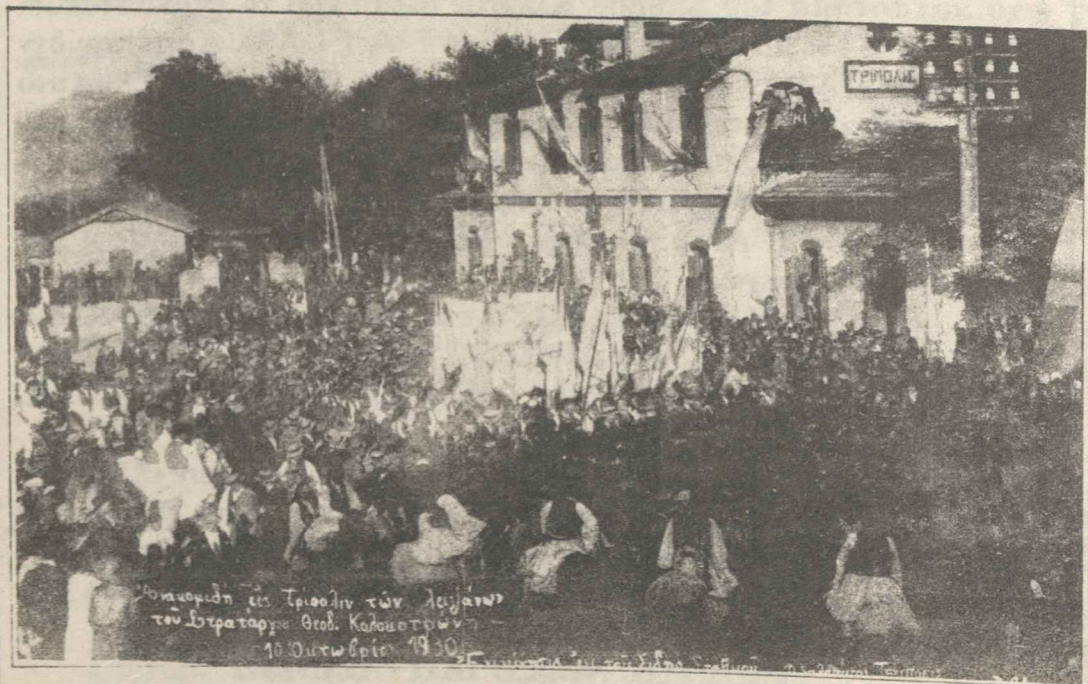
Εκκίνησης εκ του σιδηροδρομικού σταθμού, γράφει στο τέλος η φωτογραφία...
