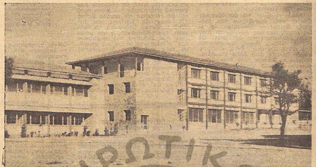
Οι νέες εγκαταστάσεις τ'ης Ριζάρειου Σχολής στο Χαλάνδρι.
